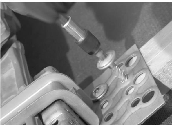
Den Dachhaken mit zwei Tellerkopfschrauben 8 x 100 (Artikel 3001240) befestigen. Es ist darauf zu achten, dass die Fußplatte formschlüssig aufliegt.
