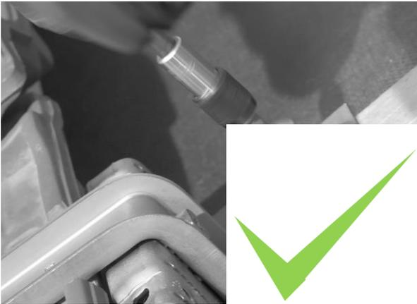
Die mitgelieferte Madenschraube dient als Stabilisierung, wenn der Dachhaken höher positioniert wird. In der untersten Stellung darf die Madenschraube nicht verwendet werden.
